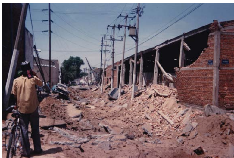
IMAGEN 1. Fotografía de la calle Río La Barca después de las explosiones
