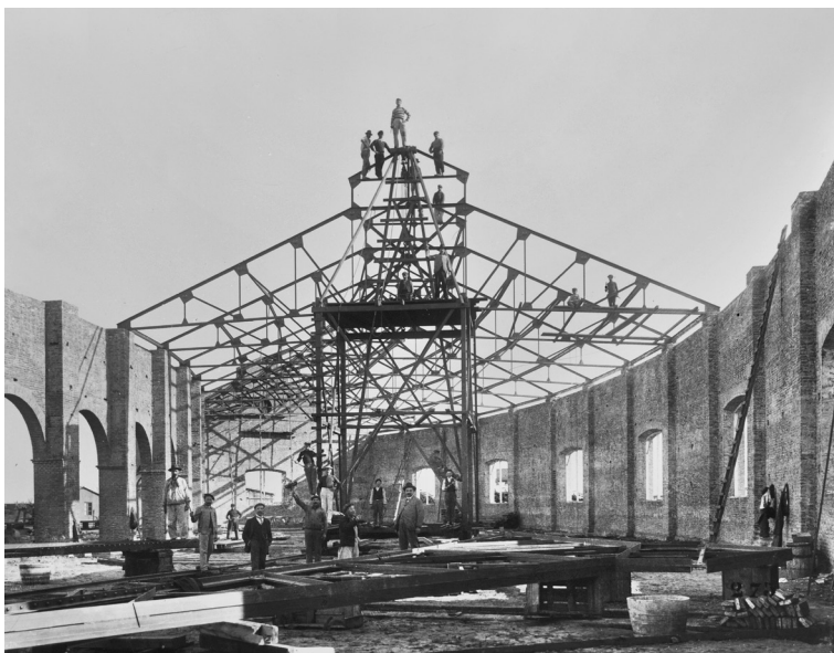
Figura 11. José Femminini. Santa Fe. Obreros trabajando en la construcción del galpón central de locomotoras del Ferrocarril de Santa Fe. Ca. 1905. Museo Regional Ferroviario de Santa Fe.
