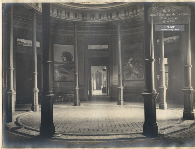
FIGURA 1. Museo de La Plata. Rotonda de la planta baja con murales. Centro de Documentación e Investigación de la Arquitectura Pública (CeDIAP) - Agencia de Administración de Bienes del Estado (AABE)- IDENTIFICACION UNICA: 0693-07539.
